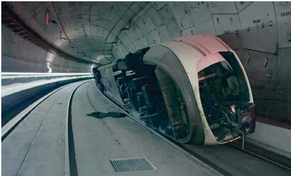
Estado en el que quedó el tren descarrilado en el túnel que une en Madrid las estaciones de Atocha y Chamartín. EUROPA PRESS
