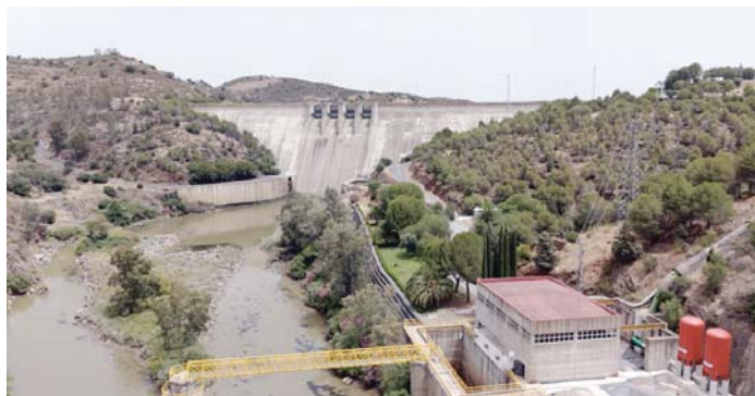
Estación de bombeo de Bocachanza, donde los regantes onubenses tienen puesta su mirada. VH
