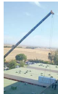
Grúa de la obra. VH
