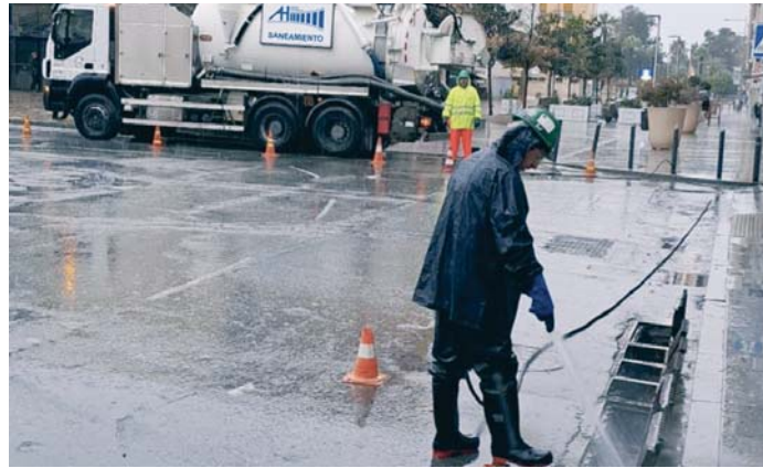
Labores de revisión de Aguas de Huelva. VH
